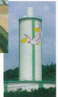
▲西岐波中継配水池設置工事
