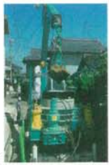
▲アート式立坑築造工事 (MMホール)
