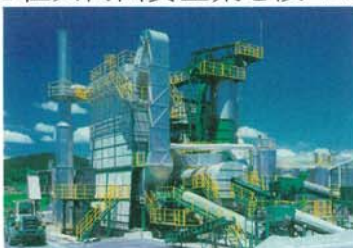
▲アスファルト共同プラント (株)サルビア アスコン
